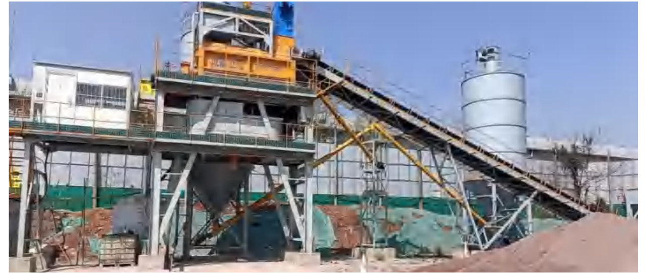
▶ 生态环保流态固化土拌合站
