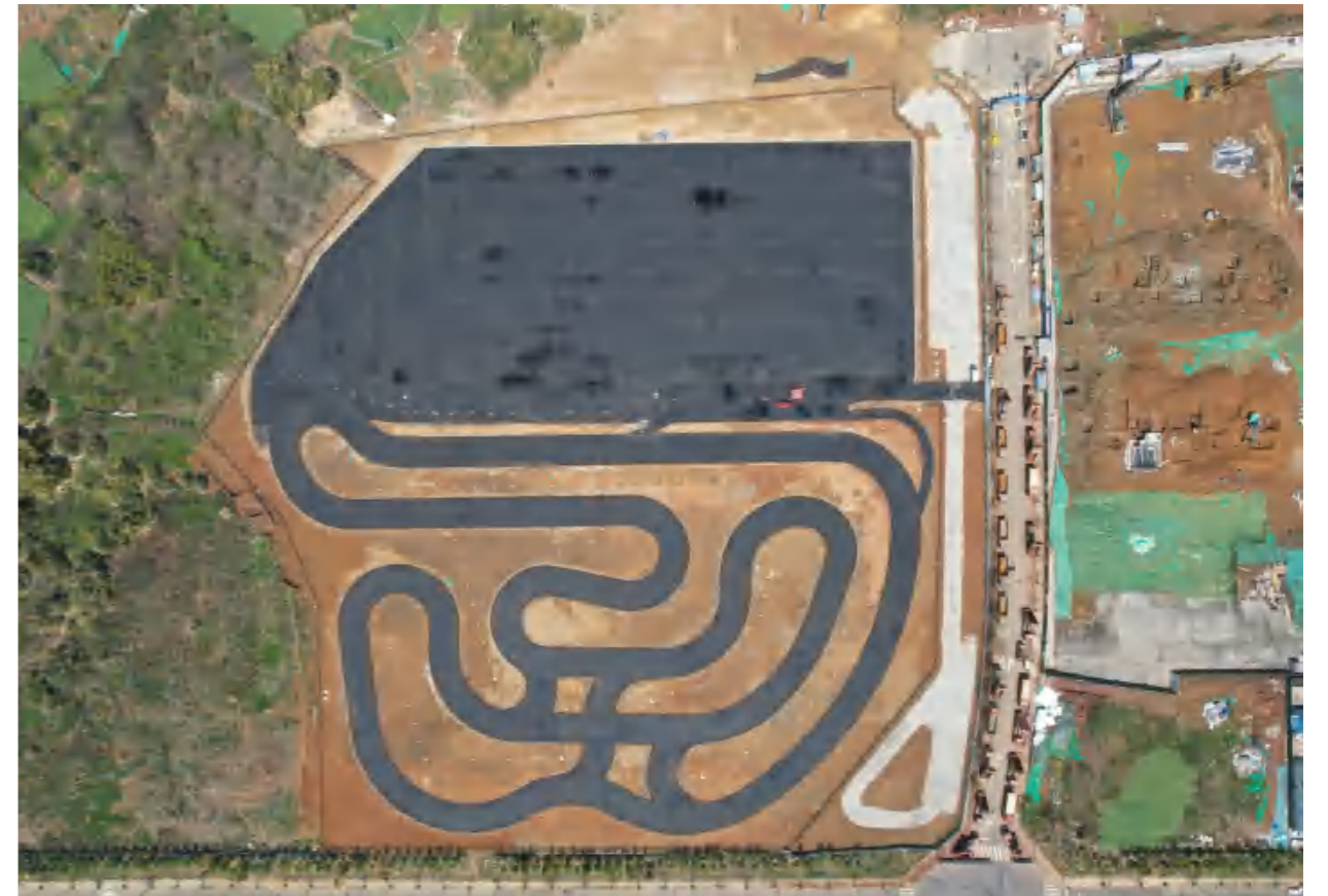
▶ 固化稳定集料在城投青和汽车文化体验中心项目实际运用
