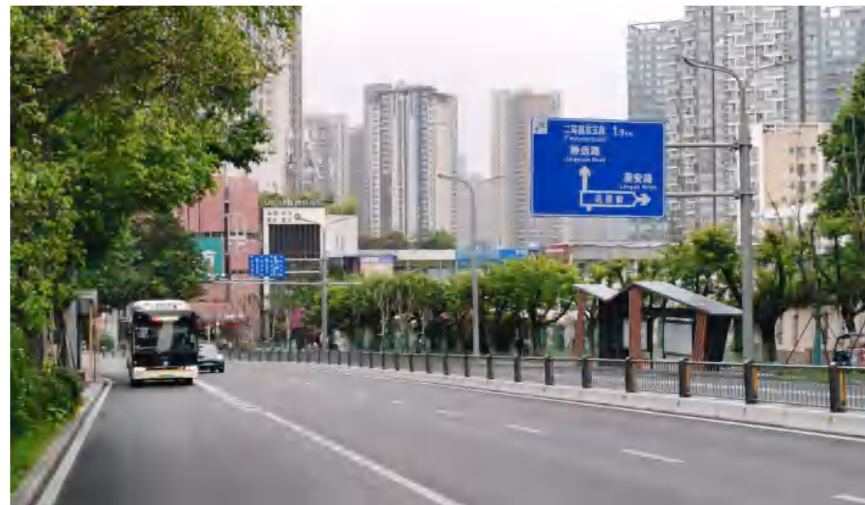
改造后的成龙路（二环路至三环路）道路
