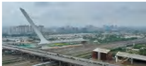
杉板桥路改造工程
